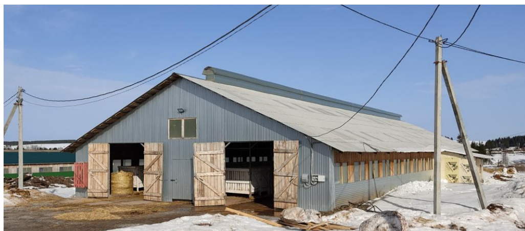
Рисунок 2 – Здание телятника в АО «Восход» Шарканского района
